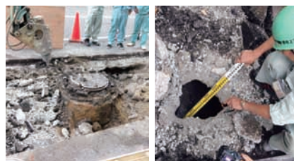
調査の結果、空洞が発見され改修
