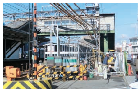
下り・改札口設置工事
