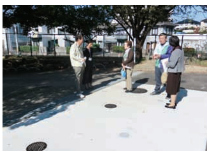
西百舌鳥小学校 北区第1号設置のマンホールトイレ (災害時は、組み立て式の囲いを設置)
