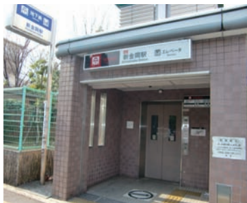
地下鉄御堂筋線“新金岡駅”
